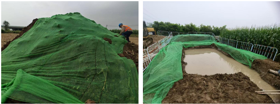
图4.3-1 临时措施照片
