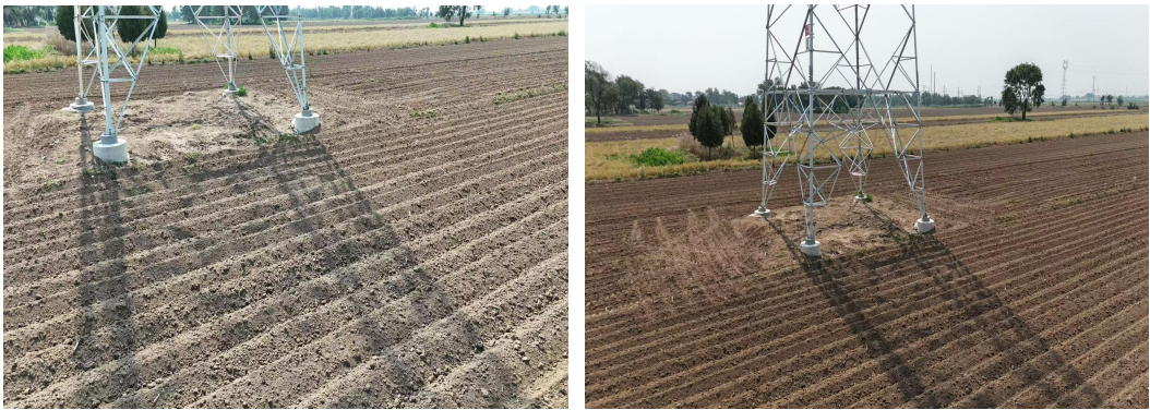
图4.2-1 工程措施照片
